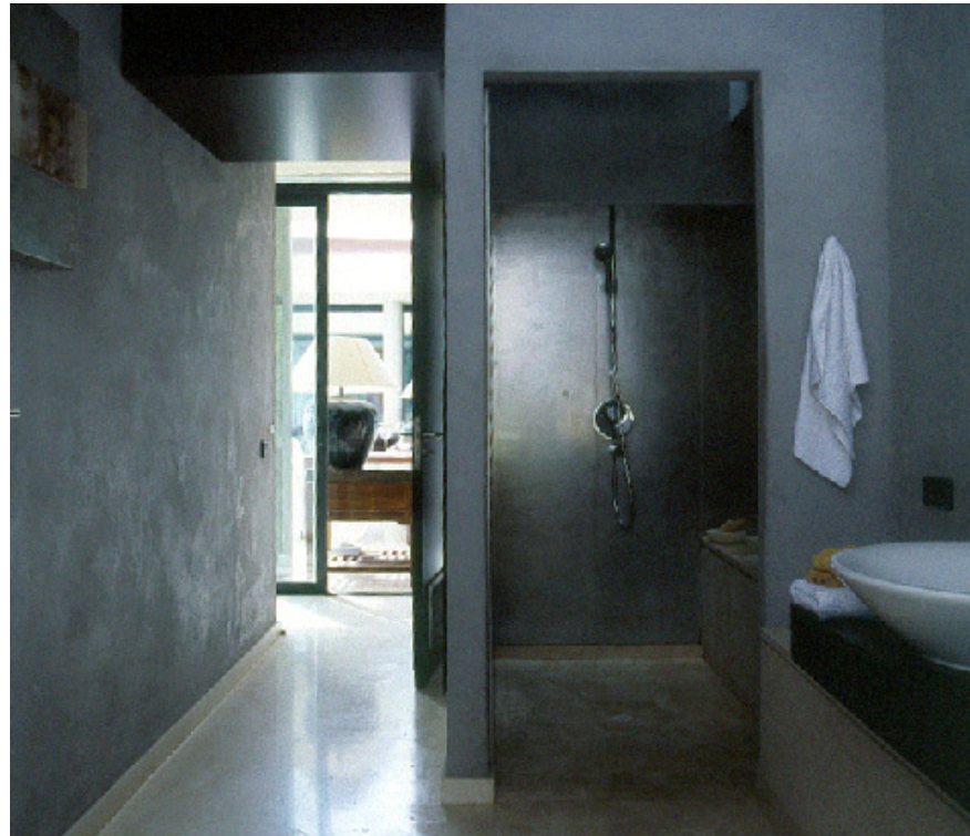
TONOS GRISES. El cemento sin pulir que reviste las paredes se ha teñido de color gris en la zona del baño. Las paredes de la ducha se han revestido con chapa de acero inoxidable.
