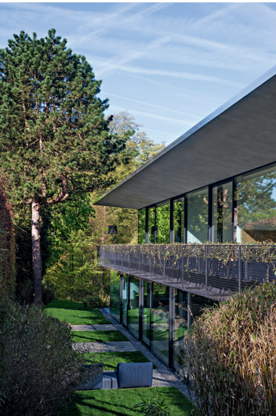
Le jeu de soutènements et de mouvements des terres rend possible la multitude d'accès vers les trois niveaux de l'habitation, sans escalier. Ici encore, de grandes croûtes de pierres bleues clivées parent les soutènements jusqu'à la piscine qui semble, elle aussi, trouver sa cuve dans les entrailles de la terre. Les pierres sont belges.
